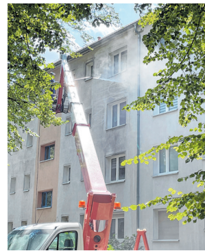
Die schmutzigen Fassaden in der Bautzener Allee werden zurzeit gereinigt. F: WH
