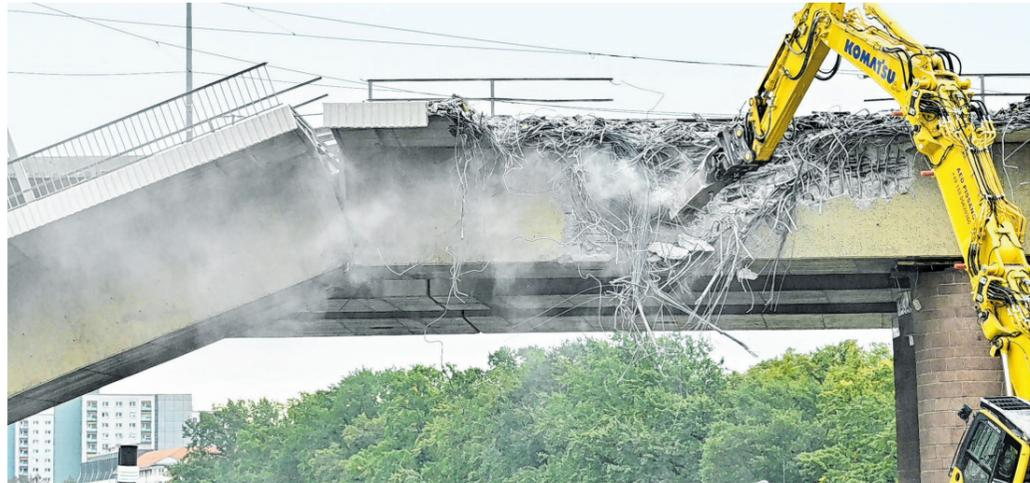
Es ist inzwischen das Symbol aus Dresden: Schneidwerkzeuge greifen in die Reste des Brückenzuges C. Auch Zug B muss abgerissen, weil er beim Einsturz zu stark beschädigt wurde. Foto: Männel
