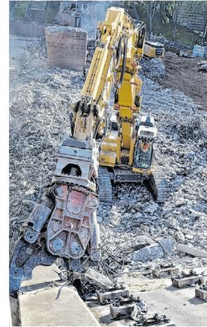
**Die schwere Technik zerkleinert Schienen und Beton.**
