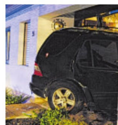
Erheblicher Sachschaden entstand an dem Wohnhaus; das Auto hatte Totalschaden. Foto: SCHWEITZER
