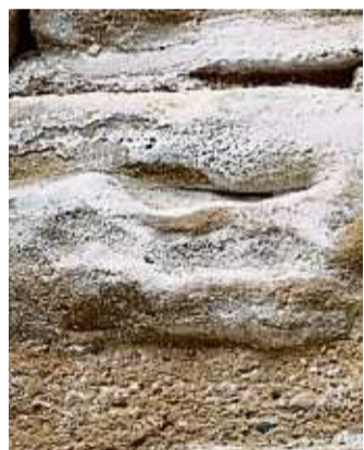
Das Salz wurde aus dem Sandstein gespült und entfernt.
